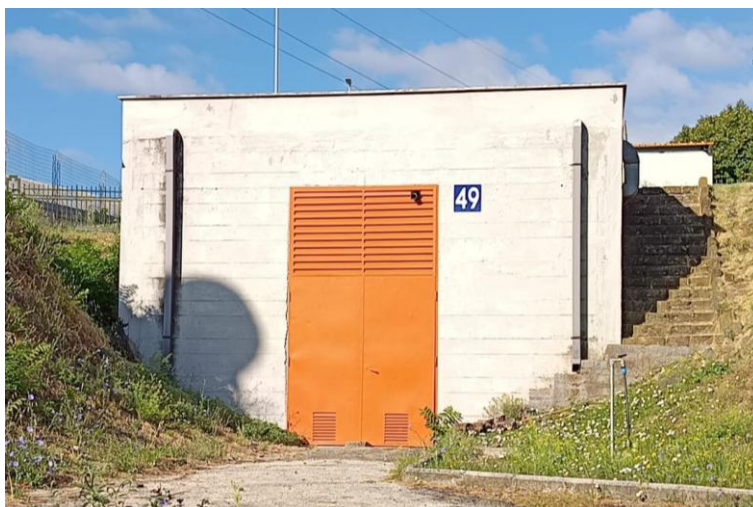
Figura 9: Ingresso all'edificio 49 (gruppo di pressurizzazione ausiliario)
